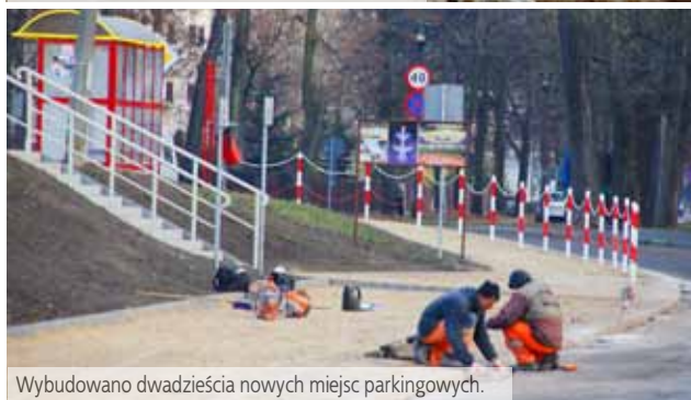
Zakres prac obejmował m.in. remont pomostu.
