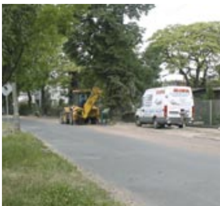
Budowa kanalizacji ul. Św. Ducha.
