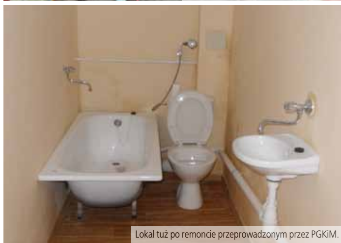
Mieszkanie zdewastowane przez lokatora.
